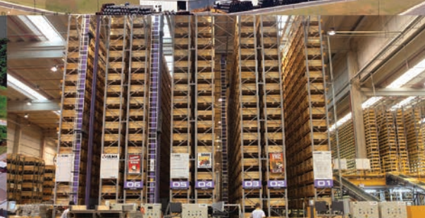
Centro de Distribuição Automatizado - Transelevadores
